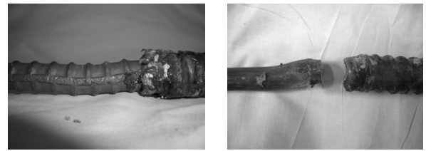
写真2 終了後の鉄筋状況
