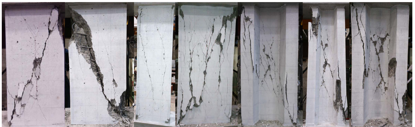
写真1 最終破壊状況
