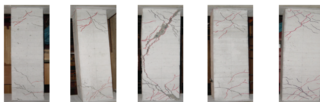
写真 1 水平加力後のひび割れ状況
