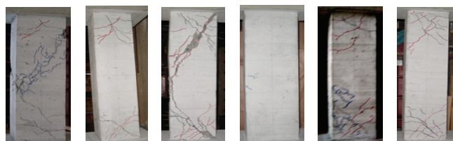
写真 2 鉛直加力後のひび割れ状況
